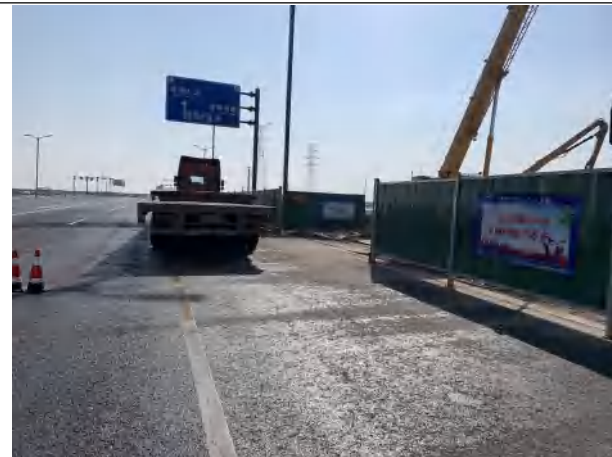
做好道路保洁，严禁带泥上路
