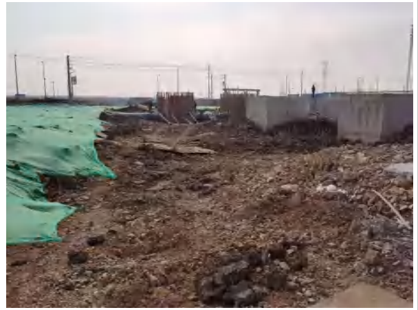
施工完成后及时清扫施工区域，做好裸土覆盖
