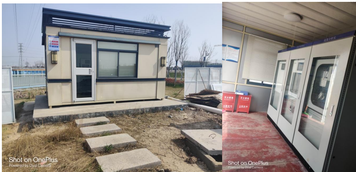
图 3-10 在线监测现场图（站房外观及内部）
