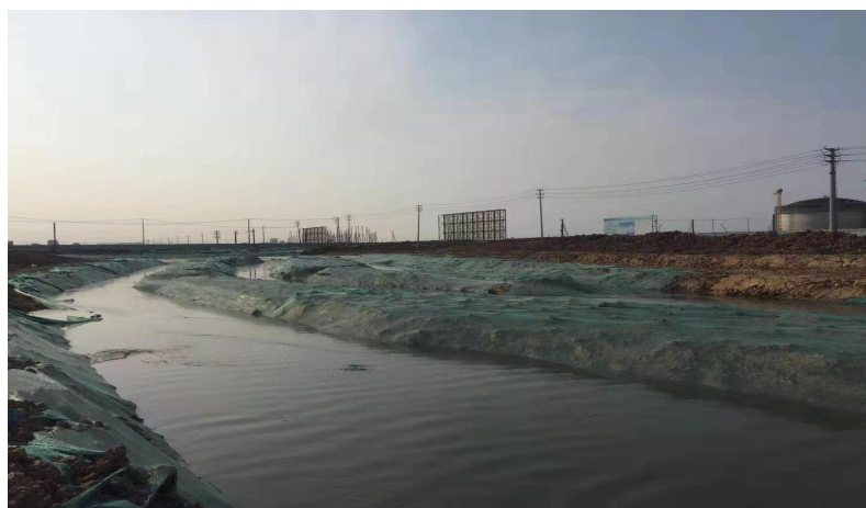
图 3-1 施工现场照片
