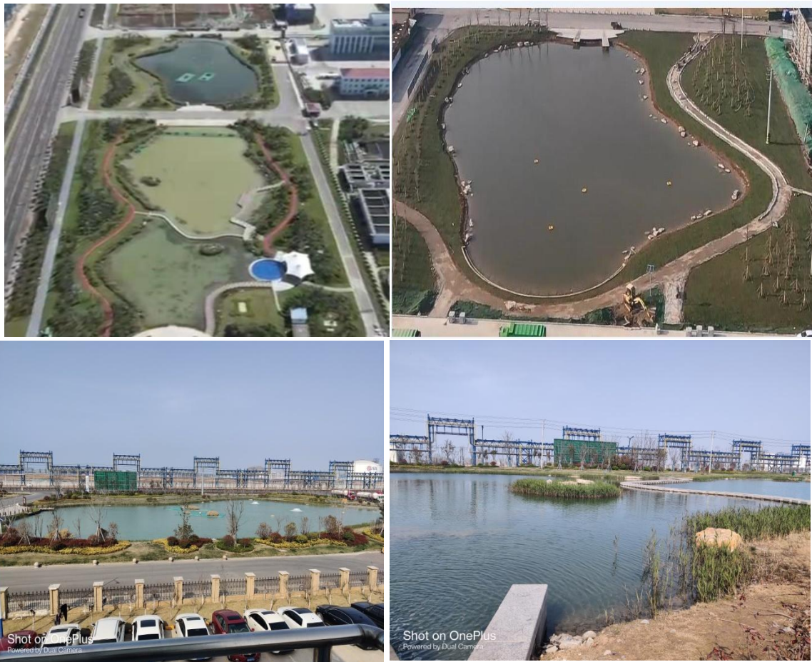
图 3-2 达标尾水净化工程绿化照片
