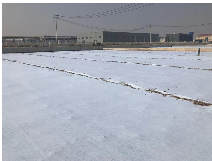
图 3-11 现场施工防渗层覆盖
