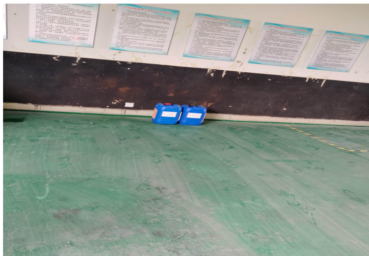
图 3-5 东港污水处理厂危废间内部
