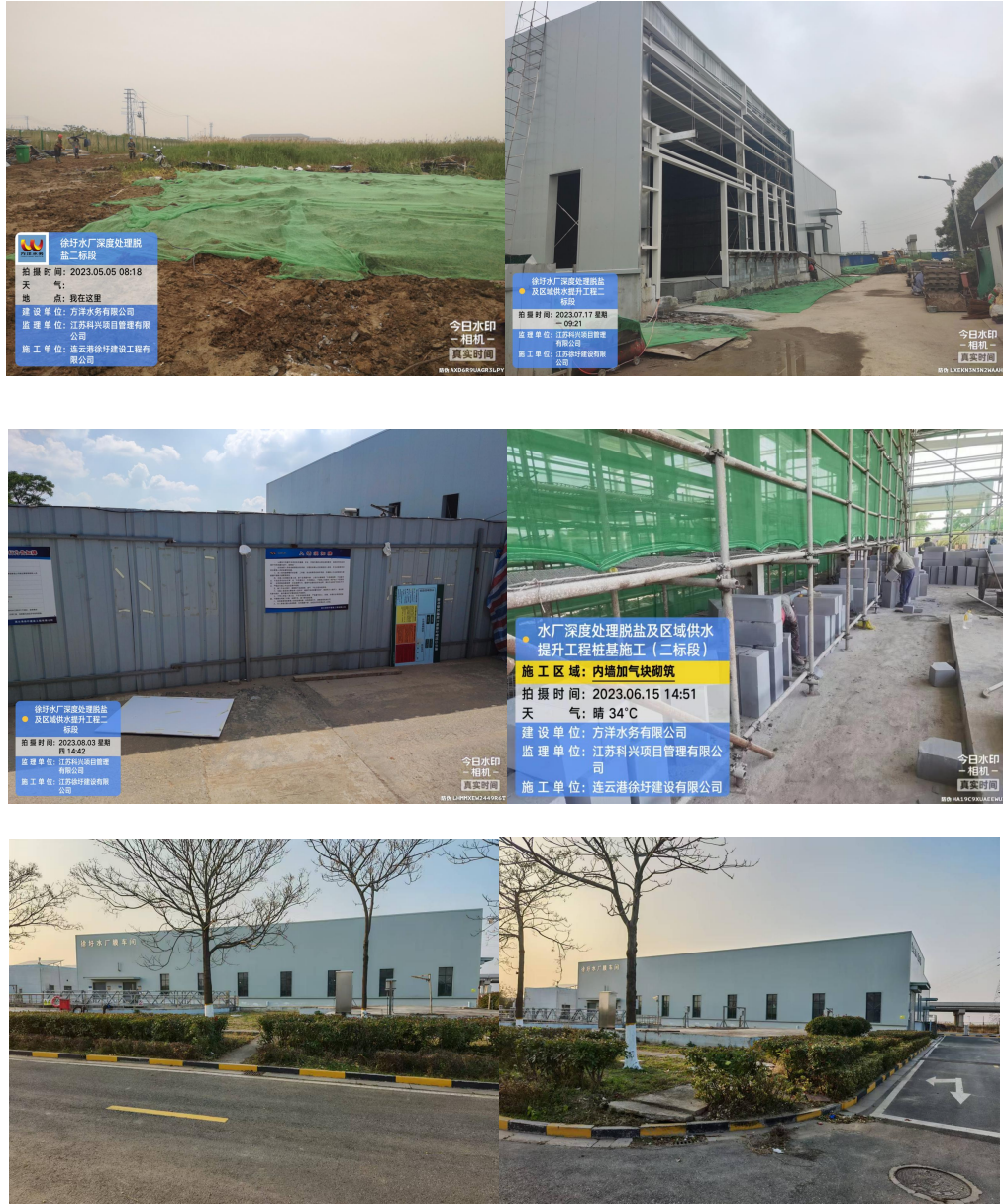
图 3-6 施工期照片（围挡、地面硬化、裸土覆盖、厂区绿化）
