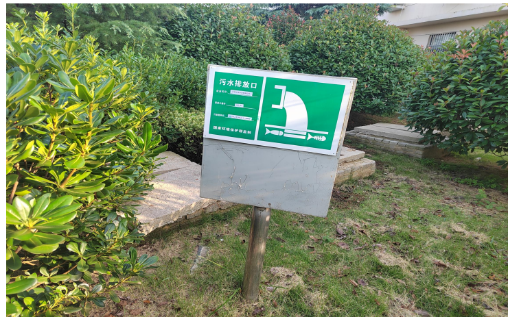
图 3-1 厂区生活污水化粪池排放口
